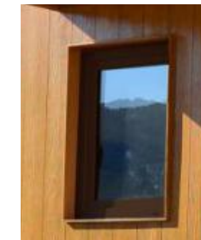
Sistema doble acristalamiento y cámara de aire con guarniciones de cemento en embocadura
